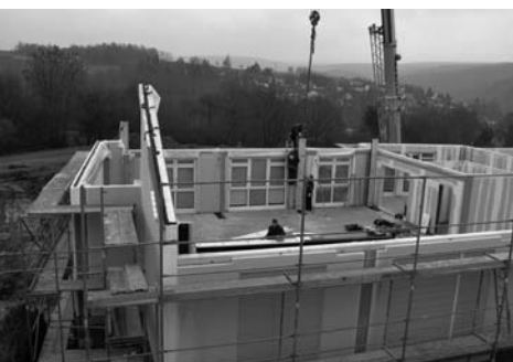
Montage der Fertigteile durch die Firma Rensch
