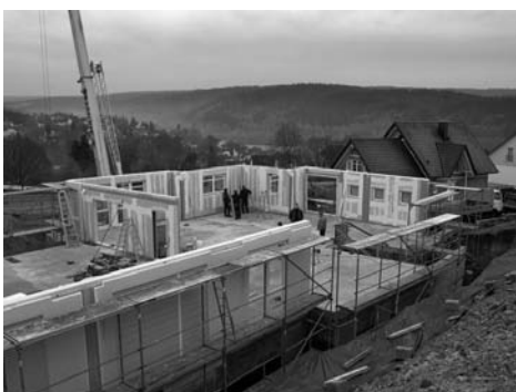
Montage der Fertigteile durch die Firma Rensch
